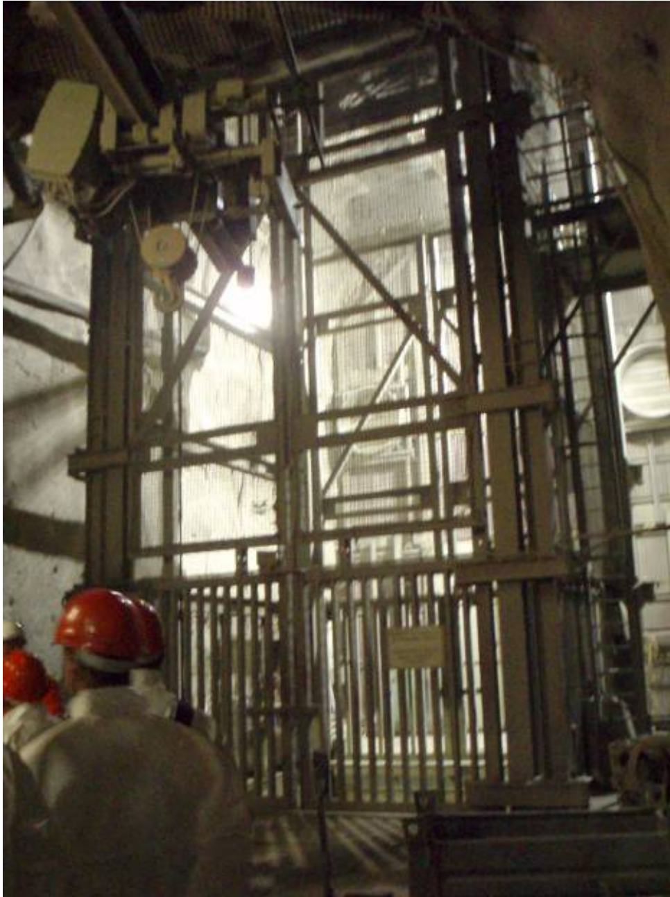
Βάση του φρέατος Sedrun στη στάθμη της σήραγγας
